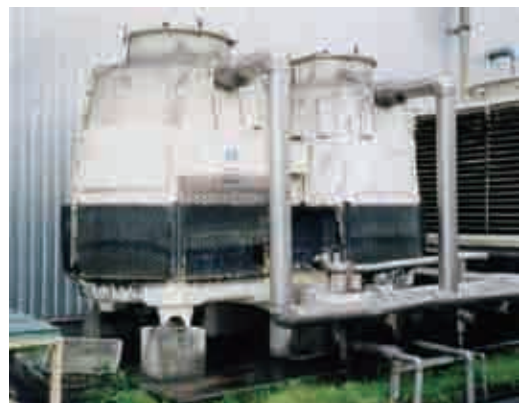
図9：向流型クーリングタワー
