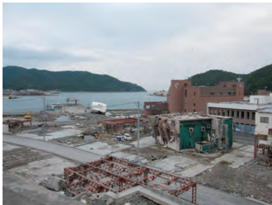
写真5 津波で転倒した建物の事例(宮城県女川町)
