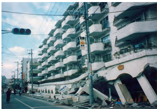
写真1 阪神淡路大震災で倒壊したRC造建物
