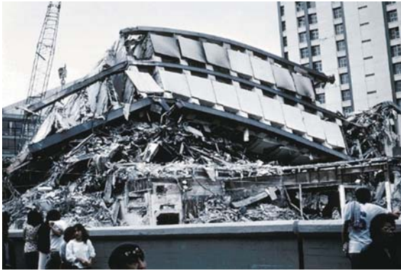
図2 1985年メキシコ地震で倒壊した21階建てアパート (写真出典：米国地質調査所)
