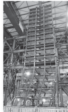
図5 E-ディフェンスの鉄骨骨組倒壊実験
